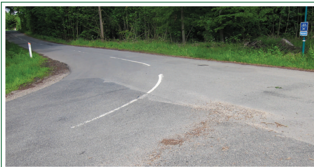
Manglende fejning samt mindre huller i vejene er eksempler på "mindre tiltag", der kan udbedres uden fornyet plangrundlag
