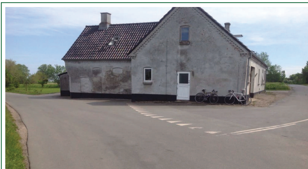
Udretning af kryds som følge af dårlige oversigtsforhold kan være forbedringstiltag med et mere langsigtet tidsperspektiv
