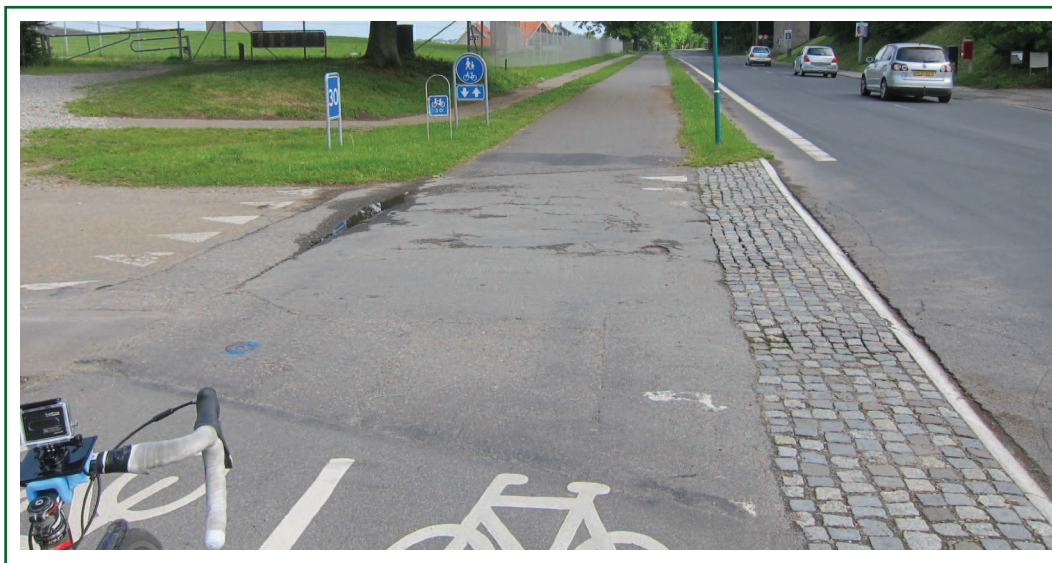
Manglende afmærkning af dobbeltrettet sti forbi sidevej kan skabe farlige konflikter mellem cyklister og ud- og indkørende biler til sidevejen.
